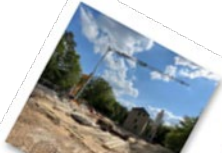
BW_AK-gebouw Vessem(Stevacon Bouw)_2
